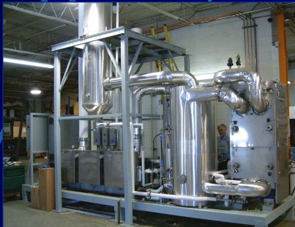
Установка по производству регенерированного гликоля в процессе монтажа в провинции Нова Скотиа, Канада
